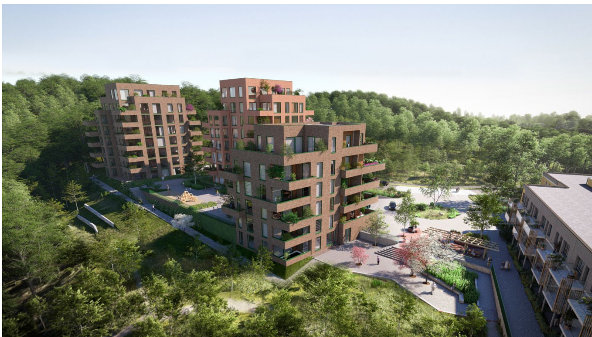
Fig. 28. Boligbebyggelse (felt BB2) til venstre og boligbebyggelse Bovieran (felt BB1) til høyre, plassert i terreng med vegetasjon, sett fra nord mot syd
