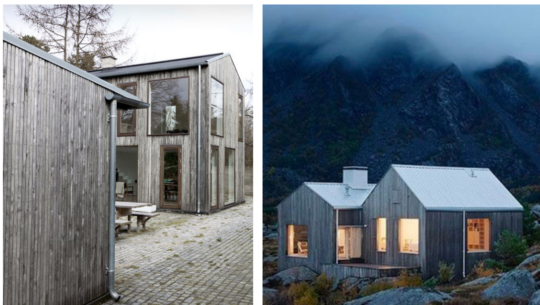
Tv. eksempel på presis og enkel detaljering av nedløpsrør og overgang tak-fasade. Th eksempel på bra integrert pipe og oppstikk i aluminium.
