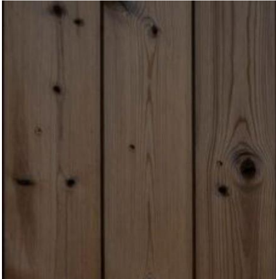
Eksempel på kledning i upigmentert varmebehandlet furu.
