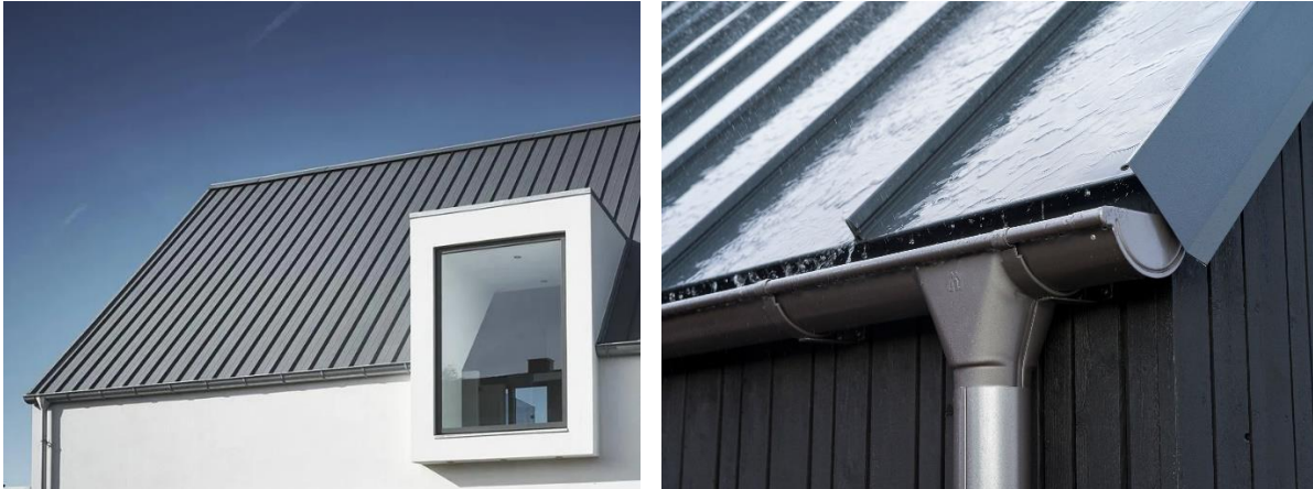
Eksempel på plannja trend 475, PL 15 mørk sølv metallic tak og detaljering rundt nedløpsrør.
