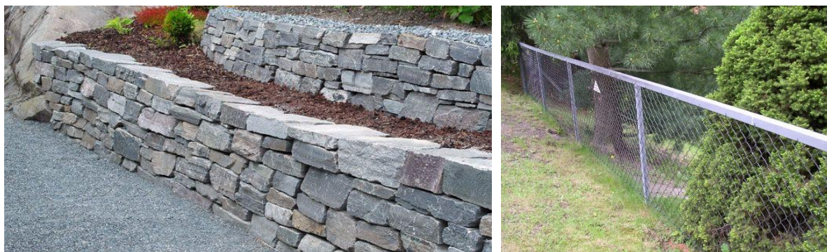
Eksempler på støttemur og gjerde: Tv. terrassert støttemur i stable stein. Th. Gjerde i galvanisert stål
