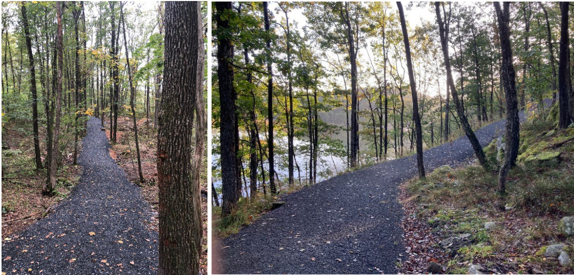
Ferdig etablert turvei i området.
